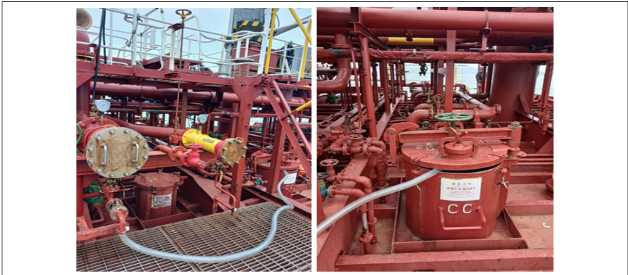
<Gambar 9> Rekonstruksi pemasangan selang untuk Air Blowing di kapal 'New Global' (milik Seongho Shipping) (dikutip dari data Seongho Shipping)
