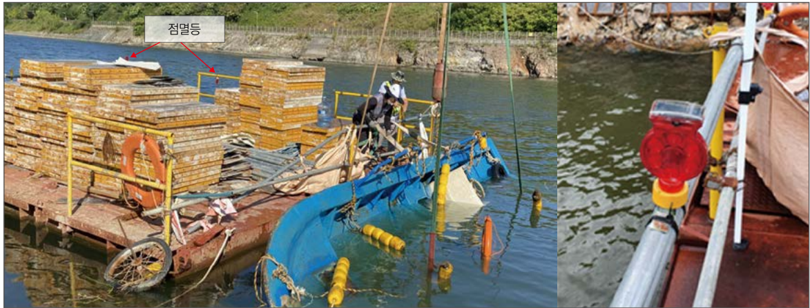
폰툰에 설치된 점멸등 및 점멸등 설치 사례
