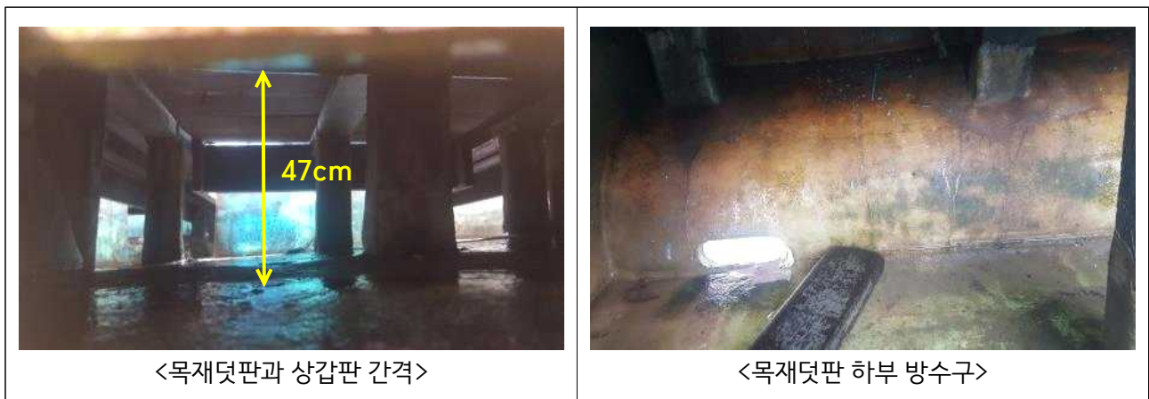
<그림 20> 목재덧판 설치
