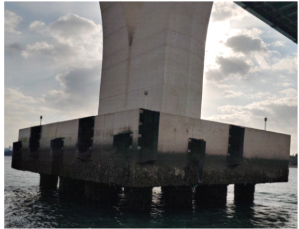
〈그림 12〉 충돌방지공 및 교각기초표시등 설치 현황
