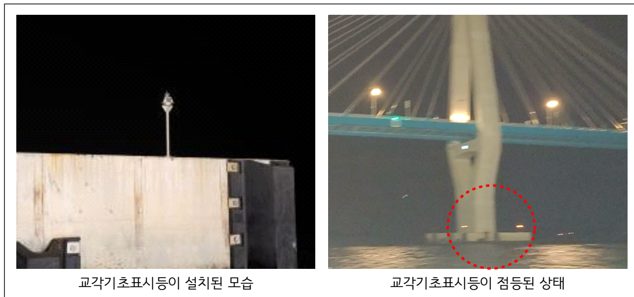
〈그림 23〉 교각기초표시등 설치 모습
