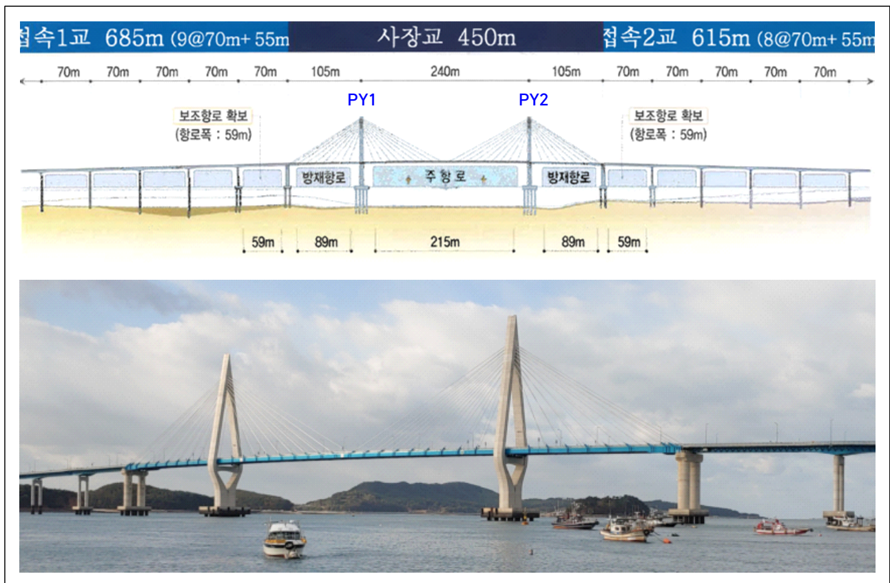
<그림 10> 원산안면대교 길이와 항로폭 및 주교각 전경
